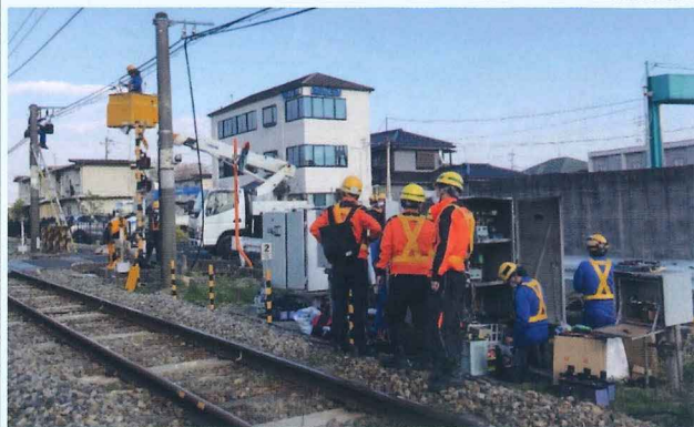
通信班は上空で新しいケーブル張り、 信号班は地上で新しい線の配線直し
