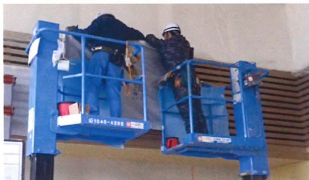
〈高所作業車を使用しているモニター設置〉
