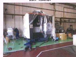
機械設置風景
