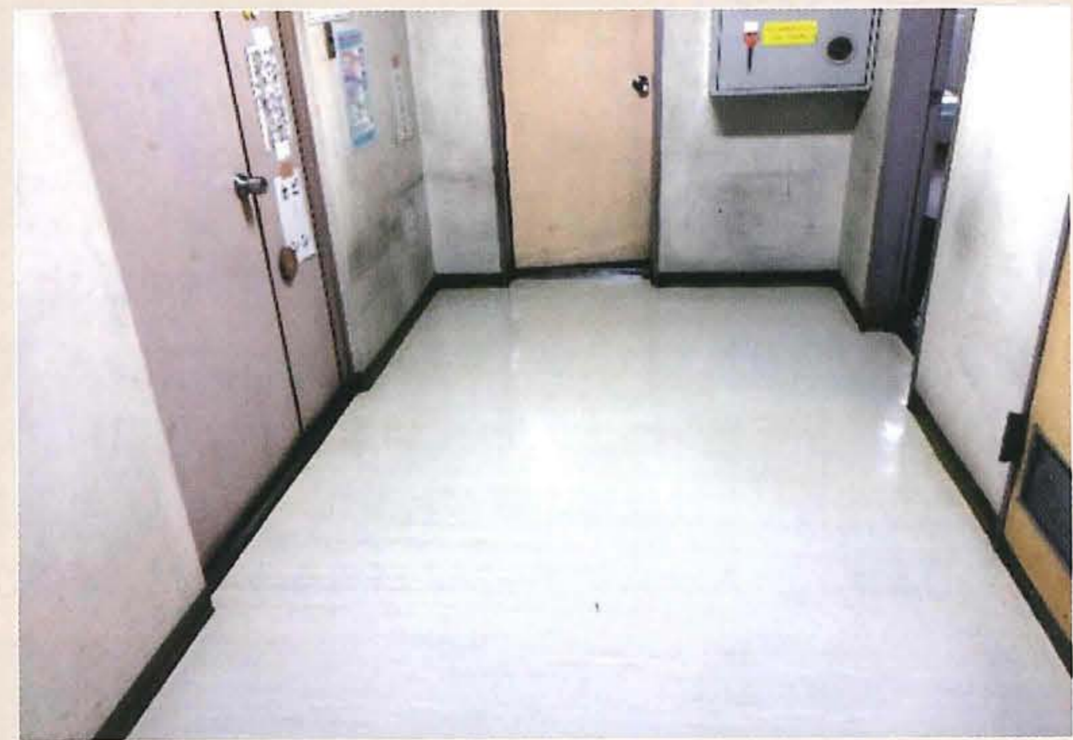
床洗浄ワックス作業後
