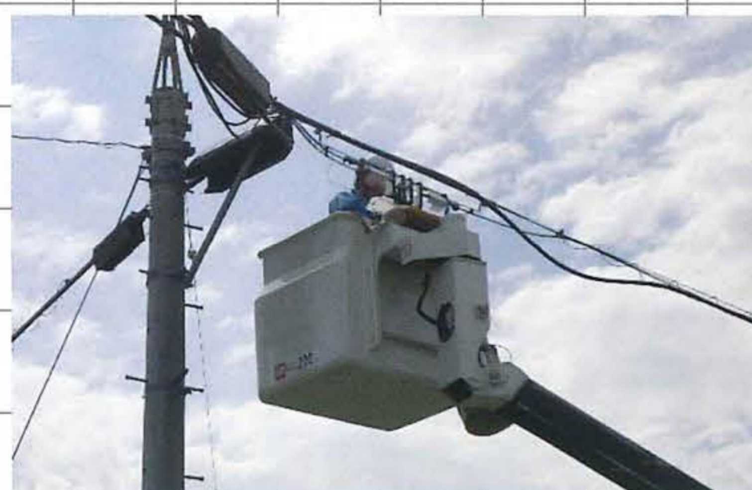
光ケーブルを接続している所です
